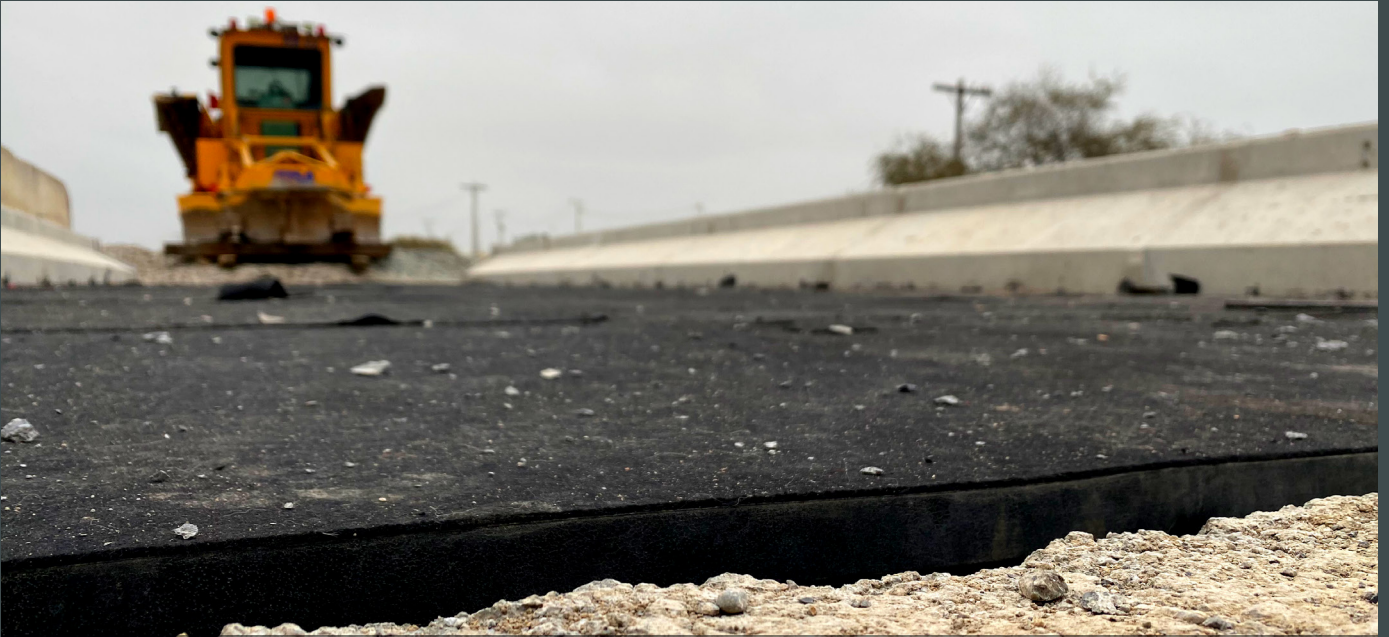
NUEVO LEON BRIDGE, MEXICO
